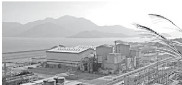
Les centrales nucléaires chinoises de Ling Ao 1 et 2 sont équipées d'ensembles turbine-alternateur ARABELLE™.
